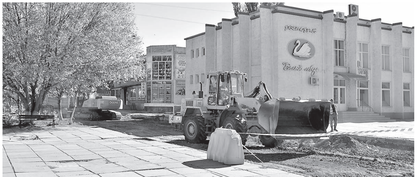
Начат ремонт проспекта 30-летия Победы в Раздольном
